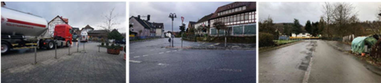
Links: Verkehrsbelastung, Mitte: Mangelhafte Fahrbahnmarkierungen Brauhauskreuzung, rechts: beschädigte Straßendecke vor dem Freibad; Quelle: cima 2021
