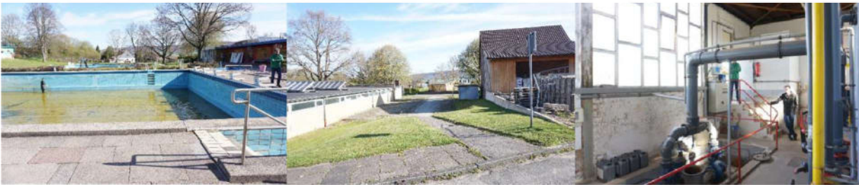
Abbildung 16: Zustand der Freibadanlage in Eschershausen
