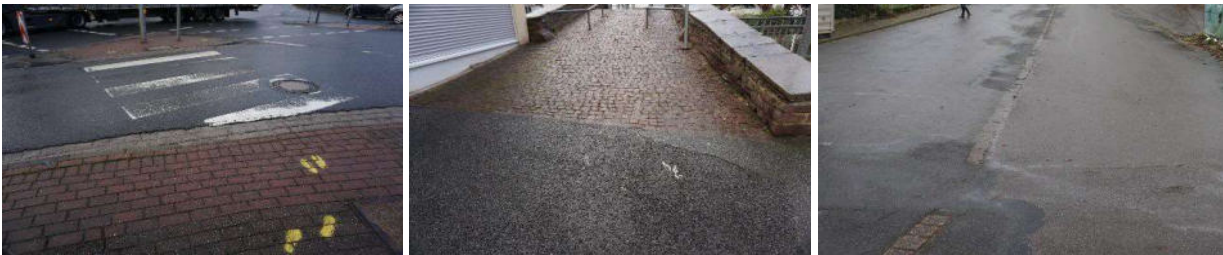
Links: Brauhauskreuzung, Mitte: Brücke über Lenne, rechts: Straße und Parkplatz vor Freibad; Quelle: cima, 2021
