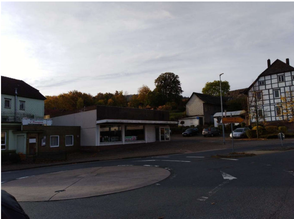
Abbildung 68: Außenansicht des Gebäudes (links) (mensch und Region 2022)
