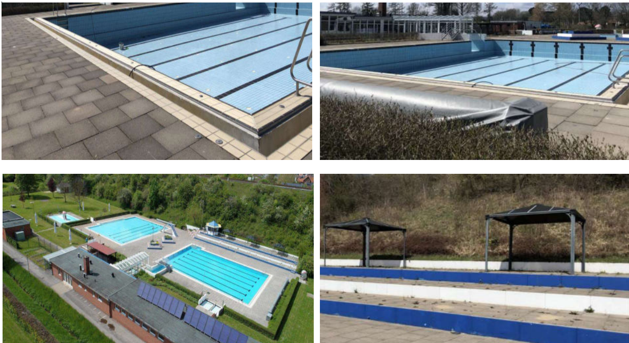
Abbildung 15: Zustand der Freibadanlage in Stadtoldendorf
