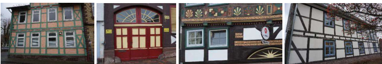
Abbildung 44: Beispiele einer gelungenen Sanierung historischer Bausubstanz
