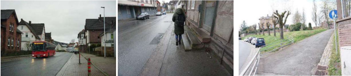
Abbildung 53: Exemplarische Verkehrsweginfrastrukturen Stadtoldendorf
